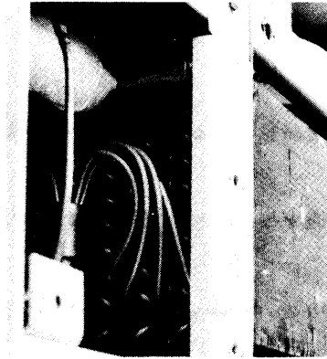
図 6-17 除霜完了サーモ
